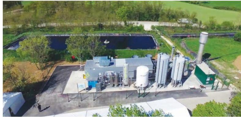
C'est sur le site de stockage de déchets de Duchy (Saint-Florentin) que Waga Energy a choisi d'installer sa première Wagabox permettant de séparer l'oxygène, l'azote et toutes les impuretés du méthane pour produire un biométhane très pur, utilisable comme du gaz naturel.
